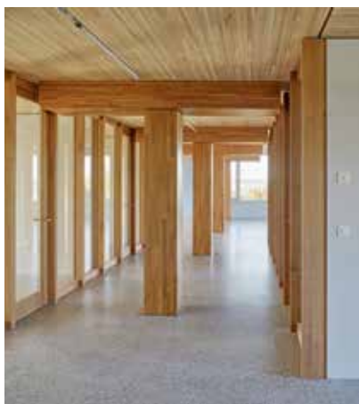
Die markanten T-förmigen Mittelstützen orientieren sich an historischen Vorbildern.
