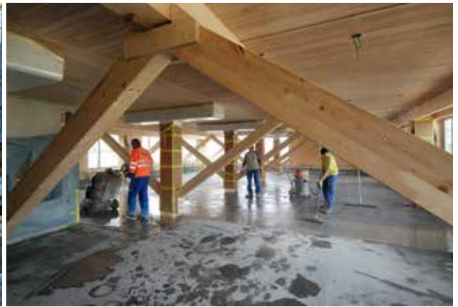
Nach dem Austrocknen wurde die Betondecke lediglich geschliffen und versiegelt.
