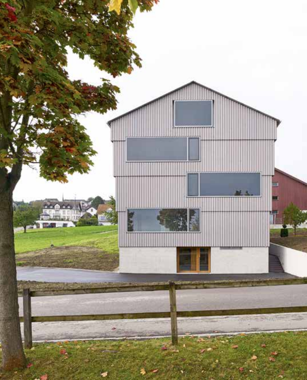
Das stehende Bauvolumen des Beratungszentrums funktioniert sehr gut als Abschluss der Anlage und bietet viel Platz für die Umgebungsgestaltung. Bild: Roland Bernath
