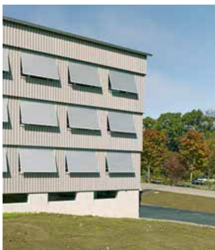
Die Überhänge der Längsfassaden von Geschoss zu Geschoss bieten willkommene Nischen für die ausstellbaren Stoffstoren. Bild: Roland Bernath
