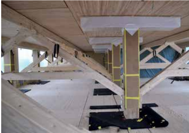
Eine spezielles Gerüst fing in der Bauphase das Gewicht der betonierten Decken ab.
