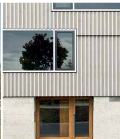
Der Haupteingang befindet sich unterhalb der Holzverkleidung, während die grossen Fenstergeschoss-übergreifend erscheinen. Bild: Roland Bernath
