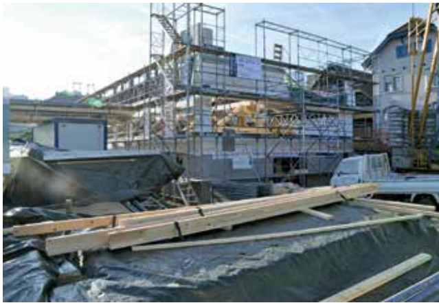
Nachdem das Sockelgeschoss und der Erschliessungskern aus Beton gebaut waren, fing man mit dem eigentlichen Holzbau an.
