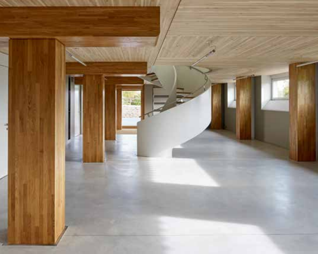
Mit Eichenbrettschichtholz ummantelt sind die Fassaden- und Mittelstützen, während deren Querriegel aus massiver Eiche bestehen. Bild: Roland Bernath
