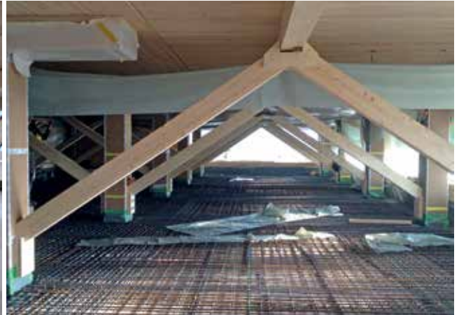
Die Deckenbewehrung wurde jeweils direkt auf die Holztafeln gelegt.
