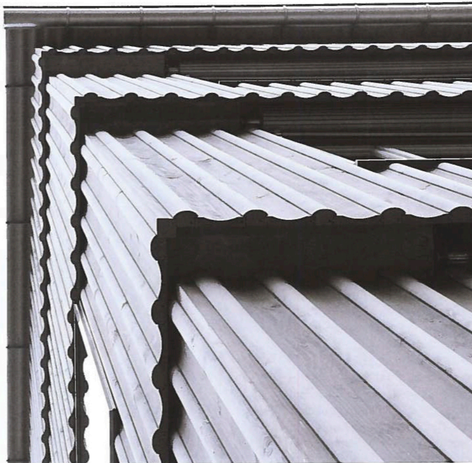
Von Nahem betrachtet gerät die Fassade des Kompetenzzentrums barock in Bewegung.
