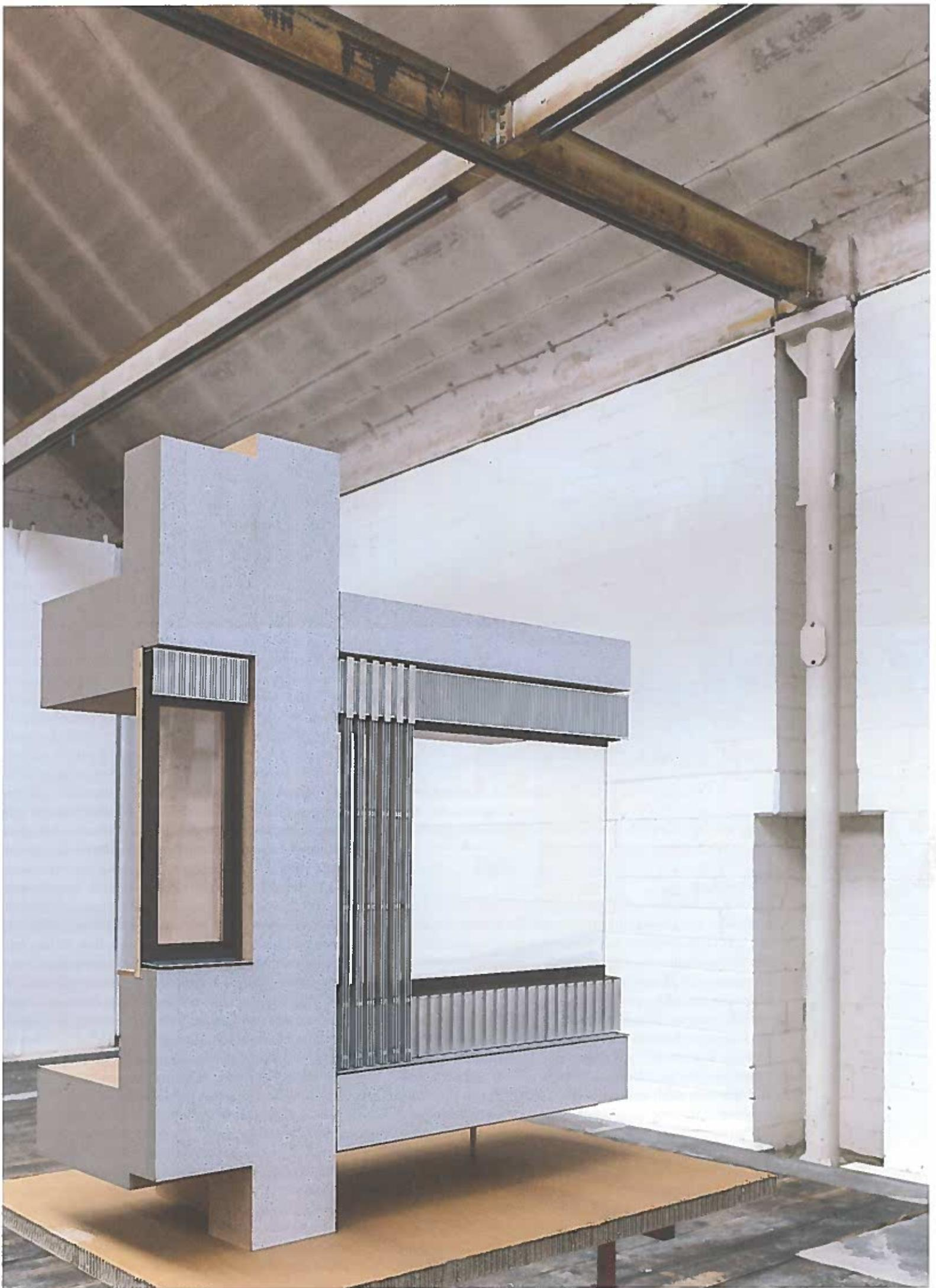
Das Spital entsteht zweimal: Bevor es aus der Baugrube wächst, konstruieren die Architekten jedes wichtige Detail im Modell. Hier das Broschenfenster entlang der Lößstrasse.
