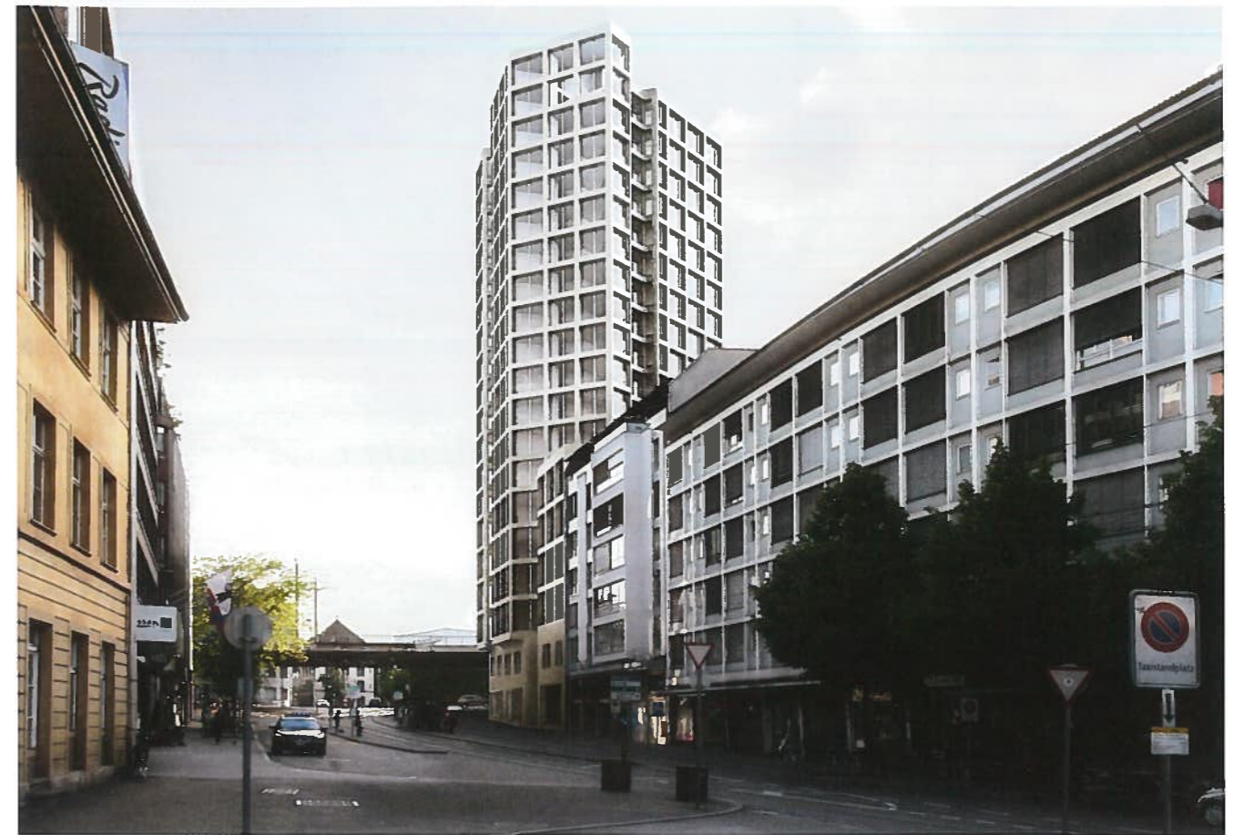
Blick aus der Steinentorstrasse
