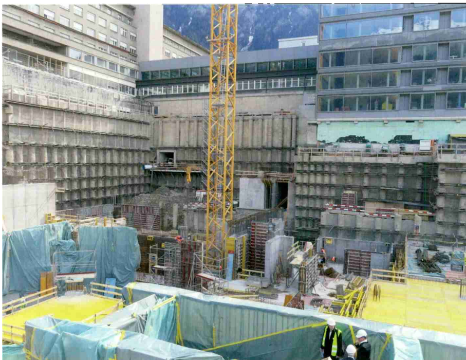
Die Usic lud Medienvertreter zur Besichtigung des Bauprojekts «SUN» am Kantonsspital in Chur.
