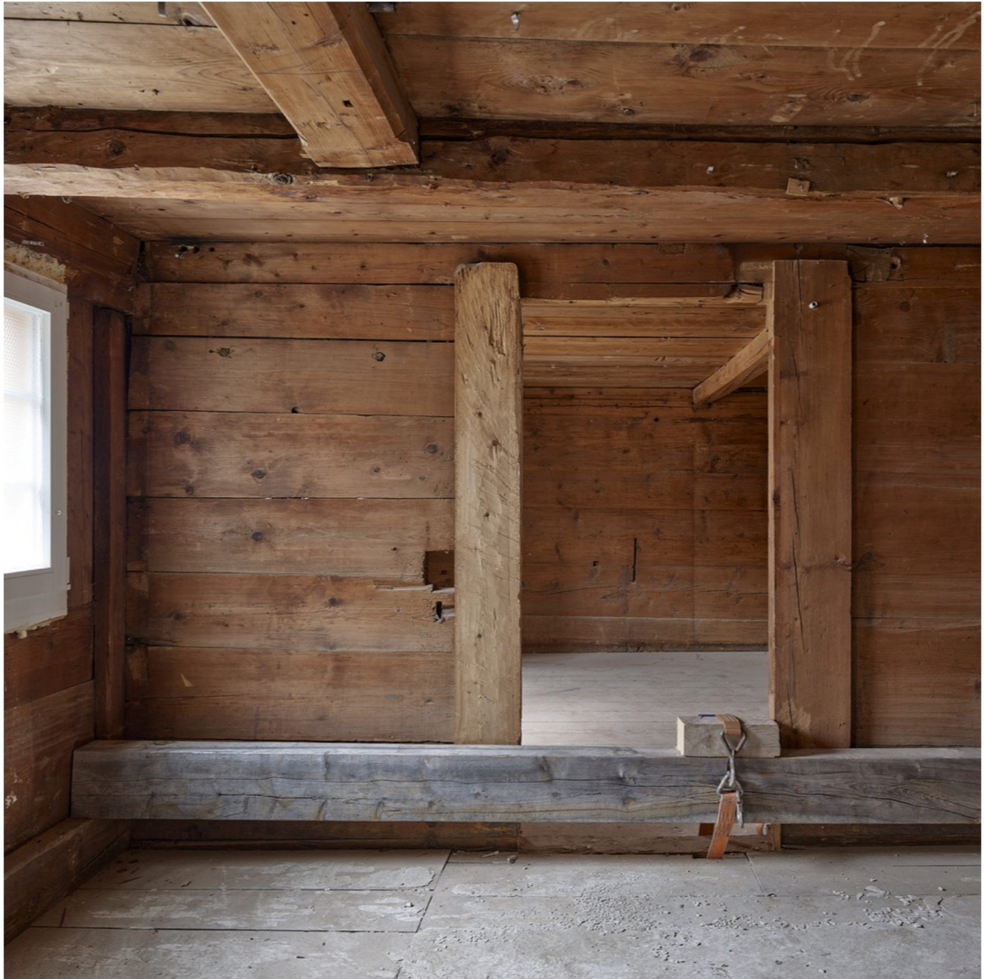
Strickwand mit Mantelpfosten. An der provisorischen Schwelle hängt die Decke des Erdgeschosses.
