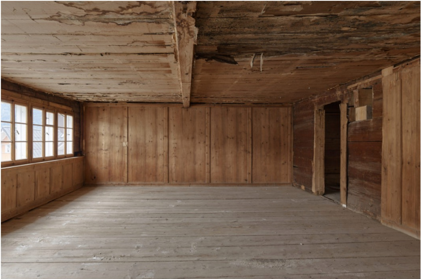
Grosse Stube mit stammbreit gesägten Täferfüllungen vor der Strickwand.
