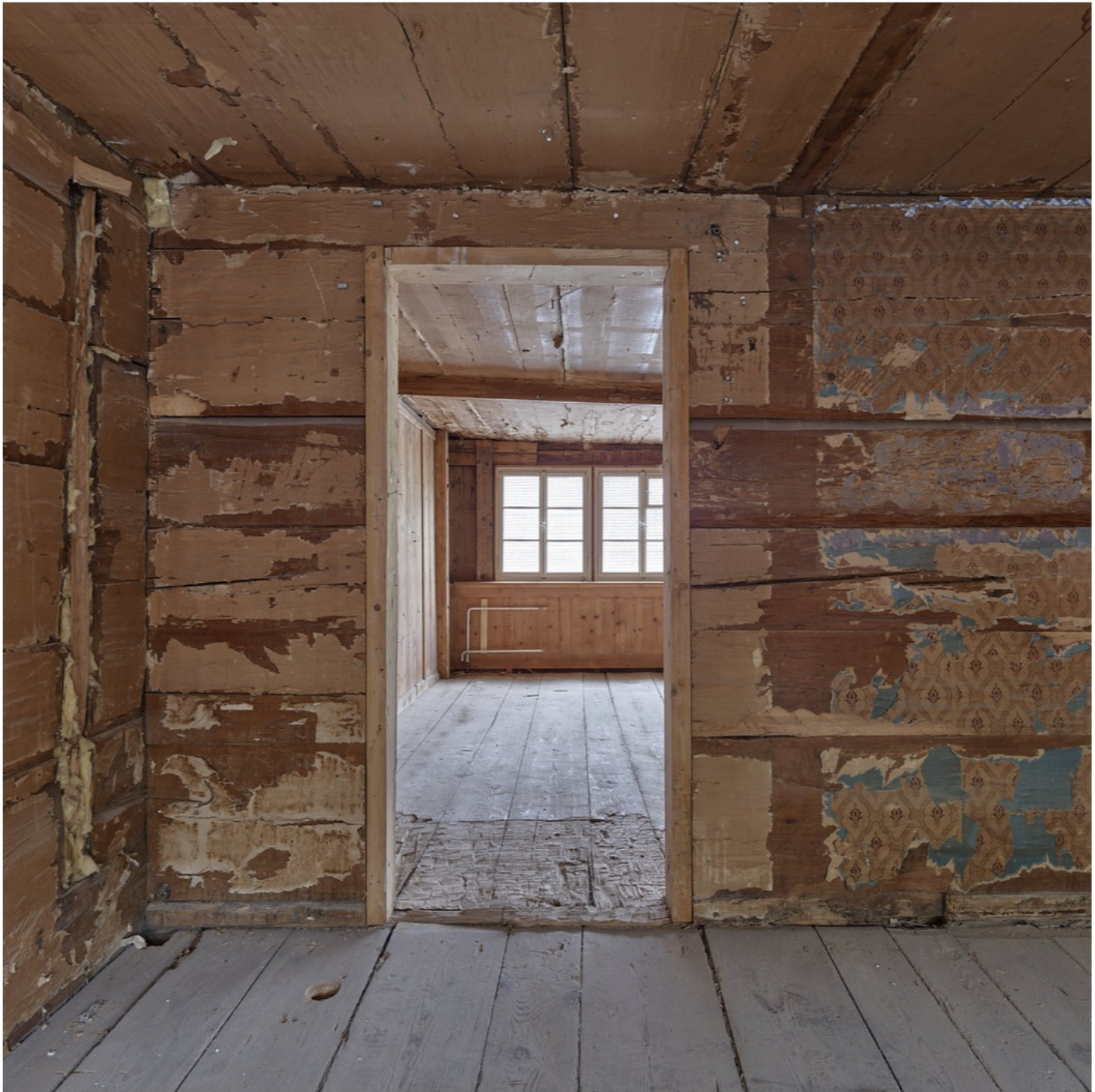
Strickwände mit Farb- und Tapetenresten allen Alters.
