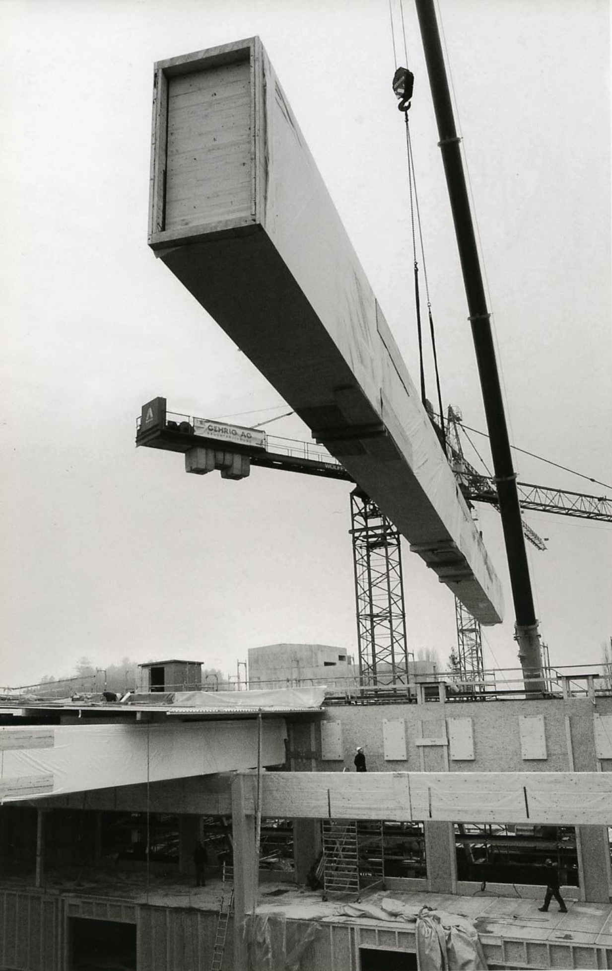
Montage der Hohlkastenträger über der Sporthalle
