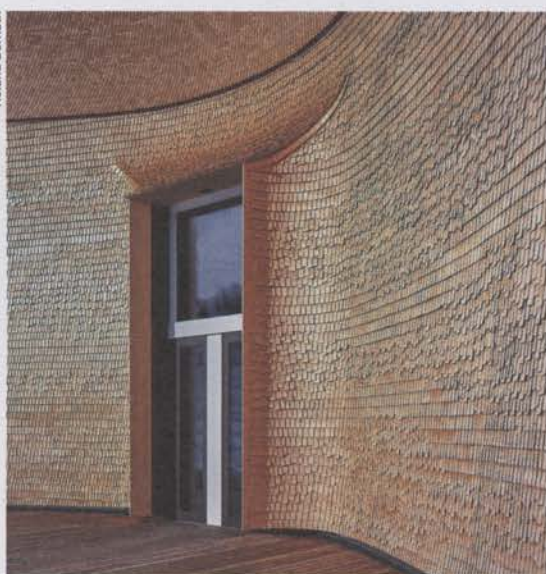
Die Holzschindeln der Fassade fügen sich zu einem rhythmischen Spiel aus Linien und Licht.
