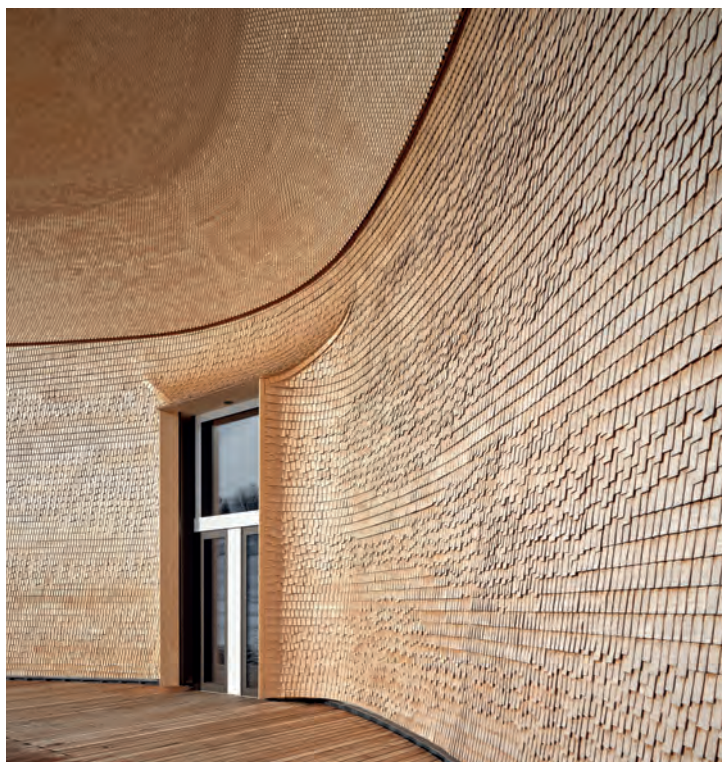
De shingles op de staande wanden zijn gelegd volgens de Schlaufschirm-methode.
