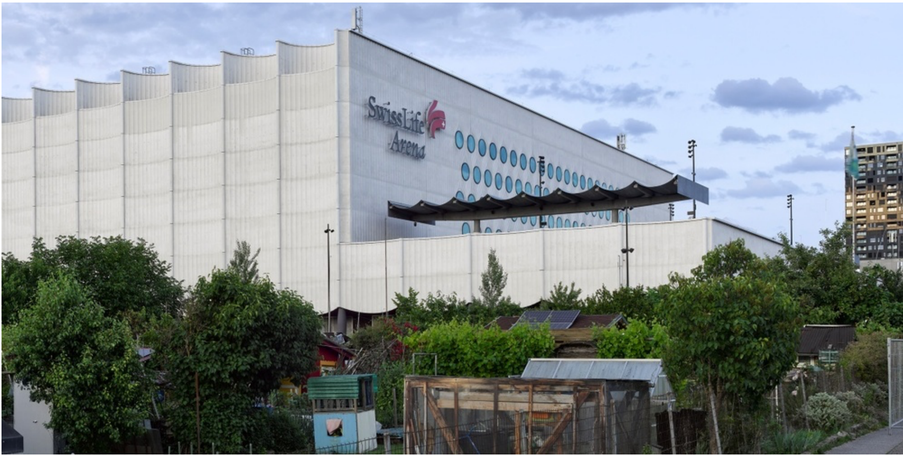
Die Swiss Life Arena in Zürich erhielt den Publikumspreis des Architekturpreises Kanton Zürich 2025 – gewählt in einer Online-Abstimmung als beliebtestes Bauwerk des Jahres. Bild: Stiftung für die Auszeichnung guter Bauten im Kanton Zürich
