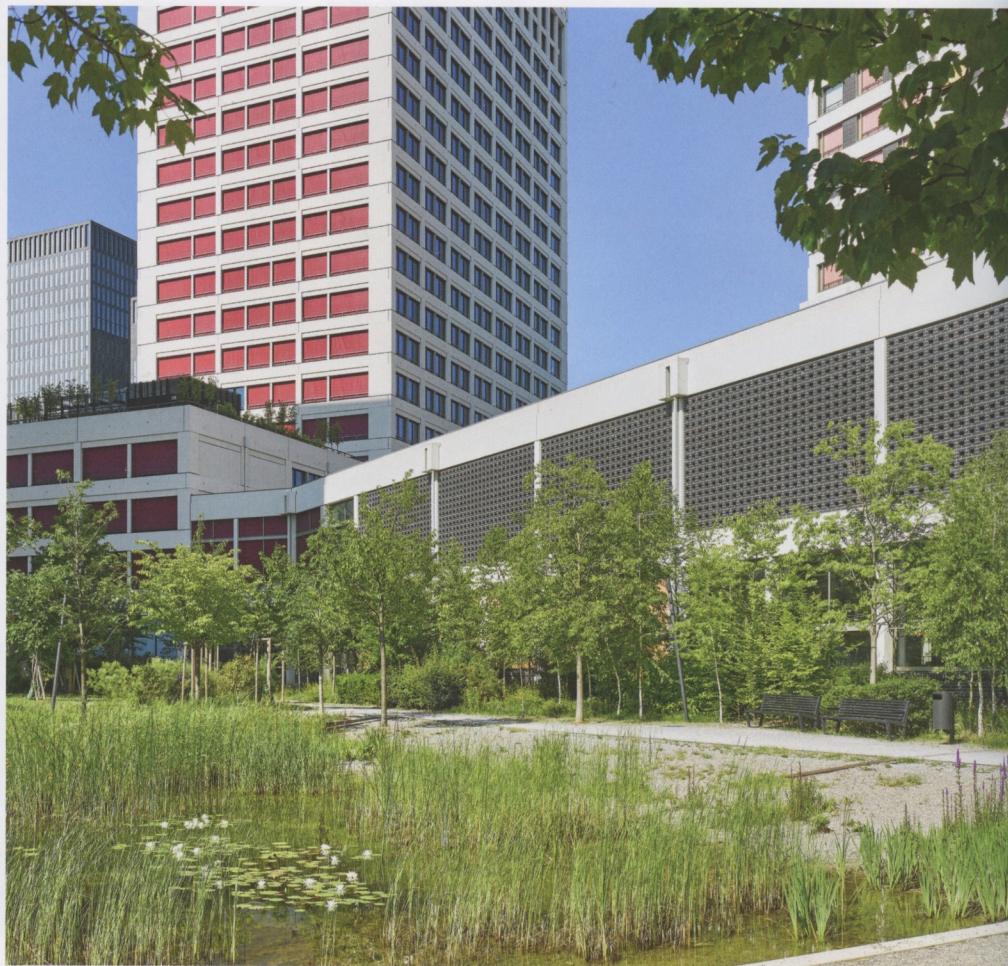
Das Hochhausensemble Leutschenbach vereint robusten, verdichteten Städtebau mit Prinzipien der Schwammstadt.
