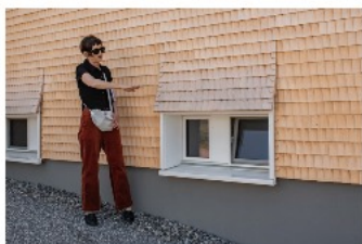
Architektin Astrid Staufer erläutert am Beispiel, wie eine Fensteröffnung mit Schindeln geschützt wird.
