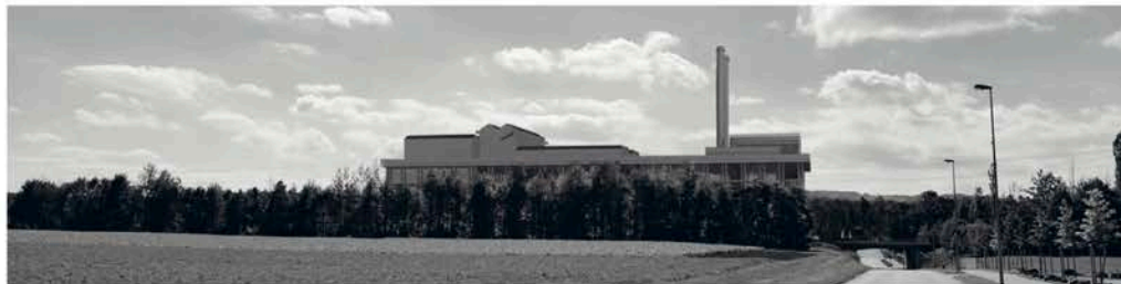
Ansicht neue KVA von Rütelholzstrasse
