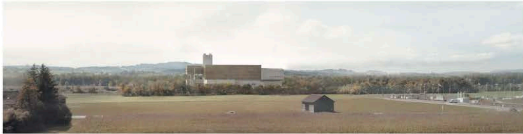
Ansicht neue KVA mit Erweiterungsbauten von Weinfeldstrasse
