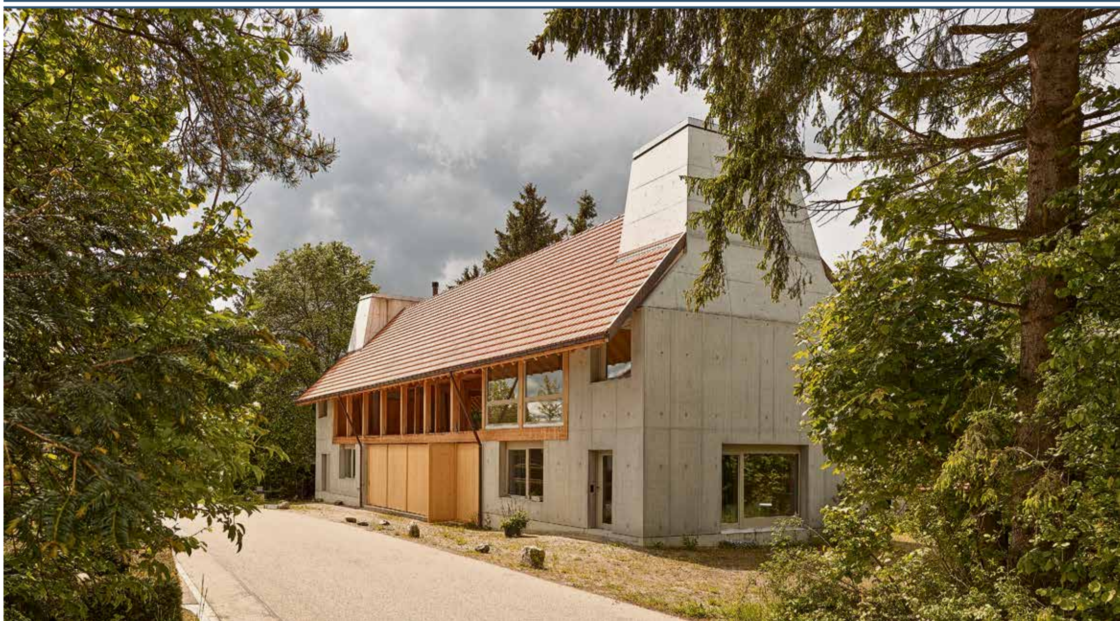
Staufers & Hasler Architekten vereinten für ein Atelierwohnhaus in Uesslingen-Buch Sichtbeton und Holz zu einer radikalen Symbiose. BILD: ROLAND BERNATH
