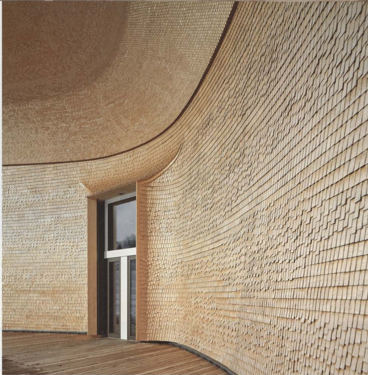
Das Klanghaus Toggenburg ist eine spannende Kombination aus Handwerk und Technologie: Die Fassadenschindeln wurden beispielsweise von Hand gespalten und per Leiterwagen zur Baustelle gebracht.
