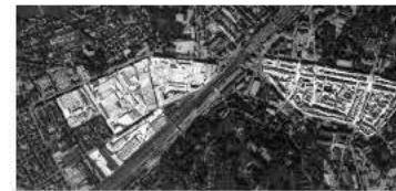
Sulzerareal und Altstadt beidseitig des Geleisefeldes
