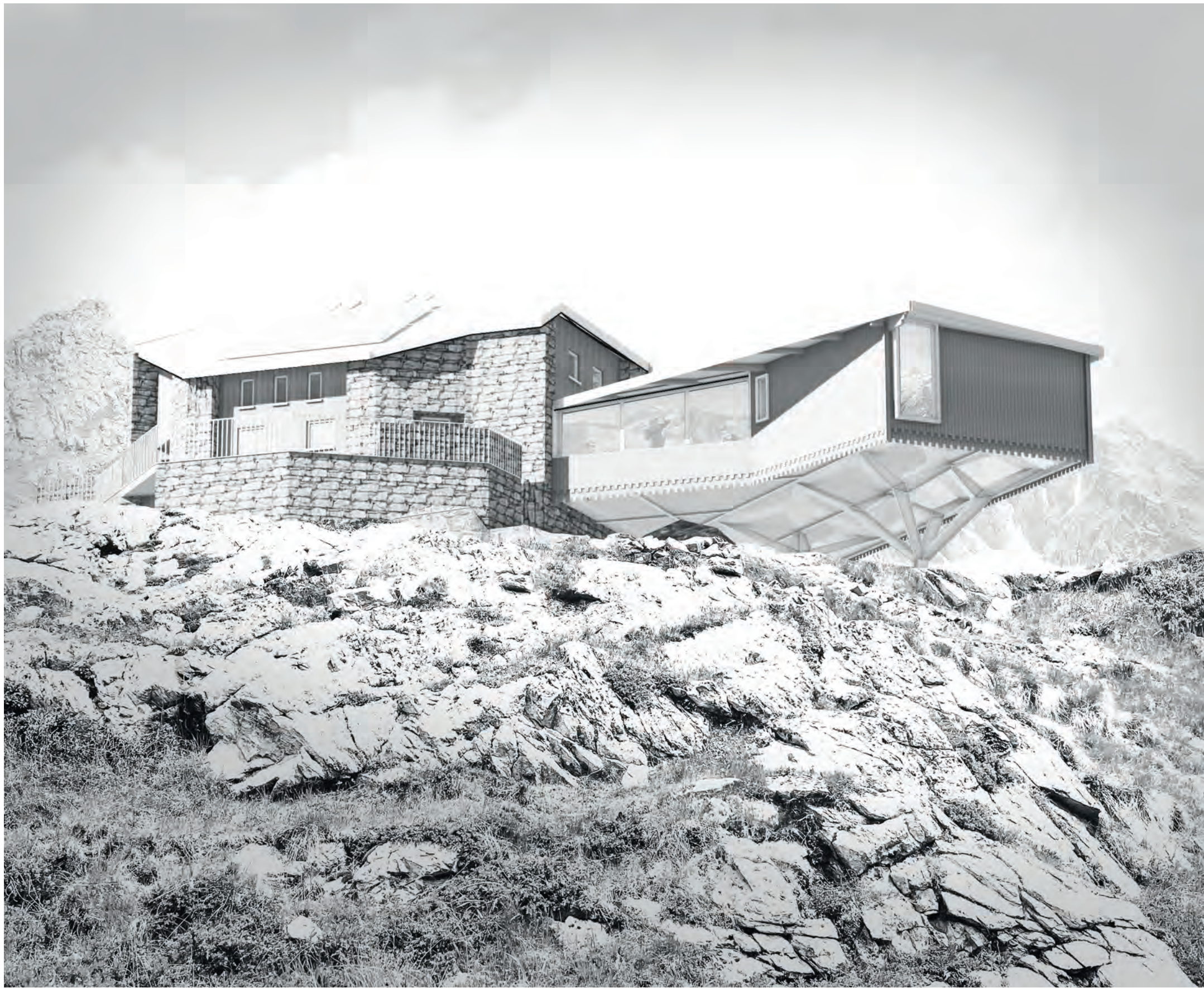
Erweiterung mit baumartigem Tragwerk aus der Untersicht
